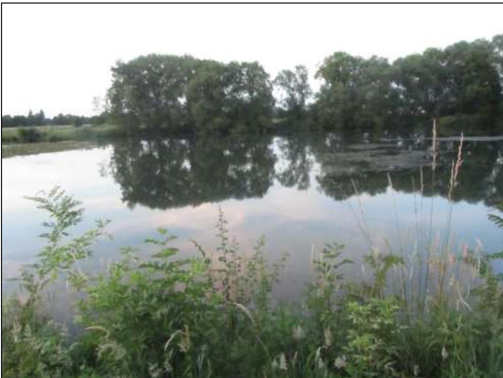
Abbildung 5: Nördliches Regenrückhaltebecken, mit dichtem Gehölzgürtel
